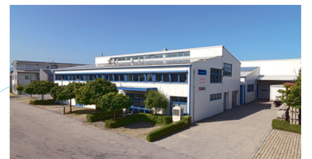
Vertriebs- und Logistikzentrum in Weilheim Sales and logistics centre in Weilheim
